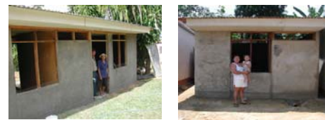
Módulos antisísmicos construidos
