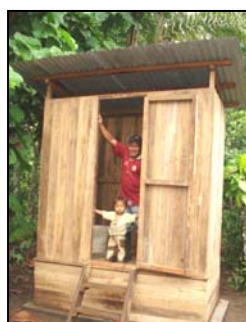
Construcción de baños ecológicos.
