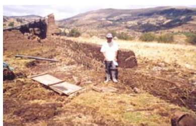
Levantamiento de muro para cobertizo
