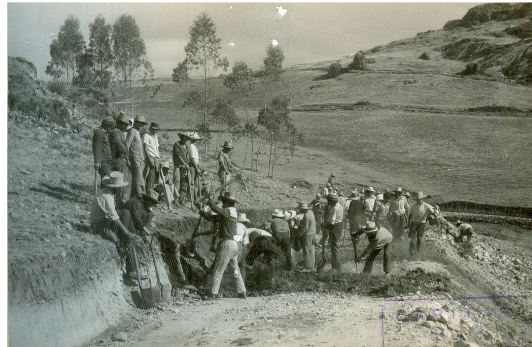
Construcción de carretera
