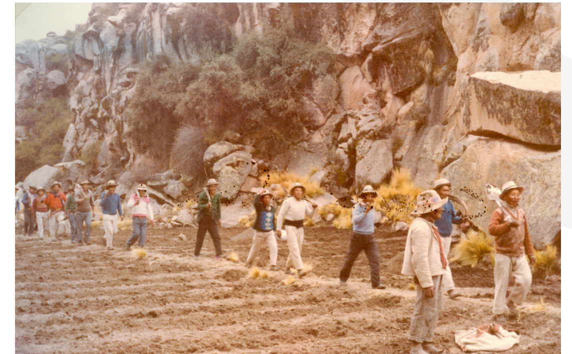
Camino a la construcción de canales
